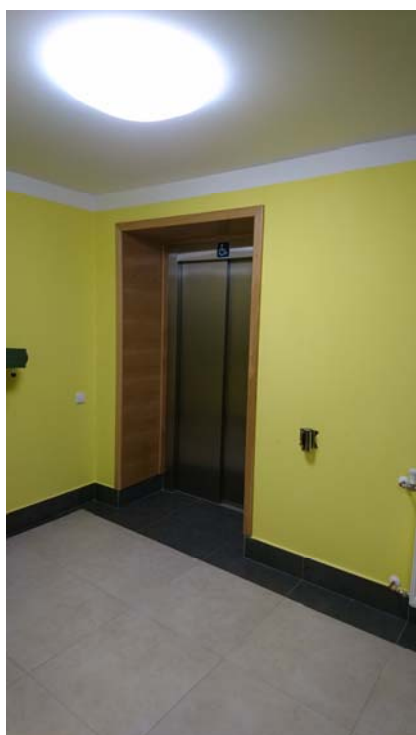
Keramický obklad 200x200, plastová ukončovací lišta tvaru L.
