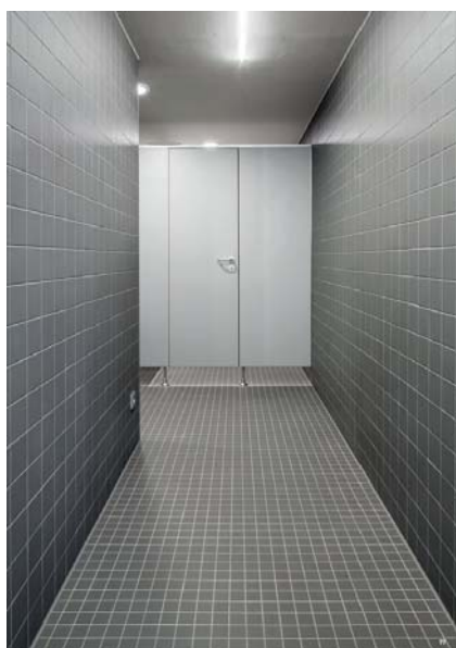
Keramický obklad 200x200, plastová ukončovací lišta tvaru L.
